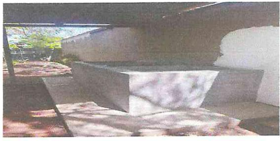
Foto 4: Fundición de pila de concreto de 3x1.30 cacidad 2200 Lt
