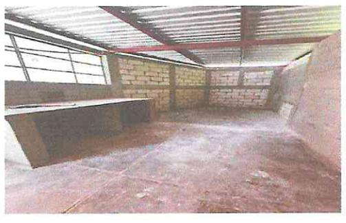
Foto 5: Cerramiento de muro perimental para cocina
